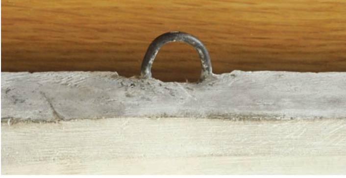
Photo 3 : Détail d'une des deux attaches métalliques Arch. dép. Nièvre
